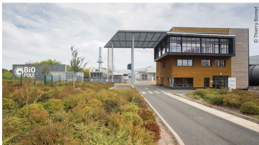
Site du futur centre de tri
