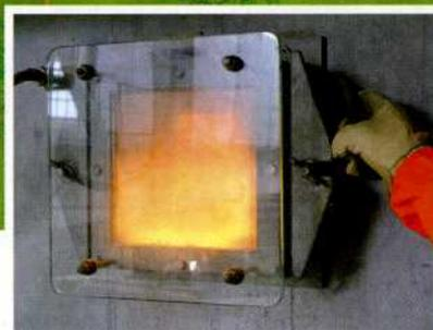
L'air injecté dans le **four** 8 pour la combustion des déchets, est aspiré dans le hall de déchargement. Cette mise en dépression évite l'émanation de mauvaises odeurs à l'extérieur de l'Unité. Il fonctionne 8000 heures par an et sa capacité de traitement est 12,5 tonnes de déchets à l'heure.
