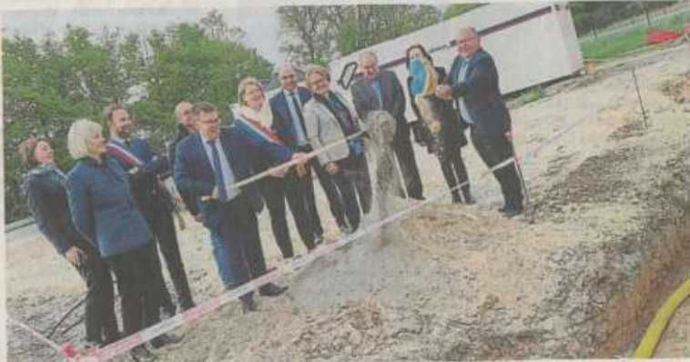
Lasse, le 28 avril. Philippe Chalopin, président de Baugeois-Vallée, entouré d'élus et différents partenaires, a procédé à une pose de la première pierre (en réalité du sable lancé sur un tuyau de gaz) de la future station GNV qui sera en service l'été prochain.
