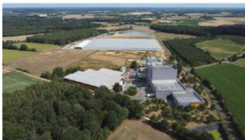
La chaleur fatale de l'usine d'incinération a permis, à proximité, un investissement de 15 millions d'euros dans des serres maraîchères. (CSivert)
