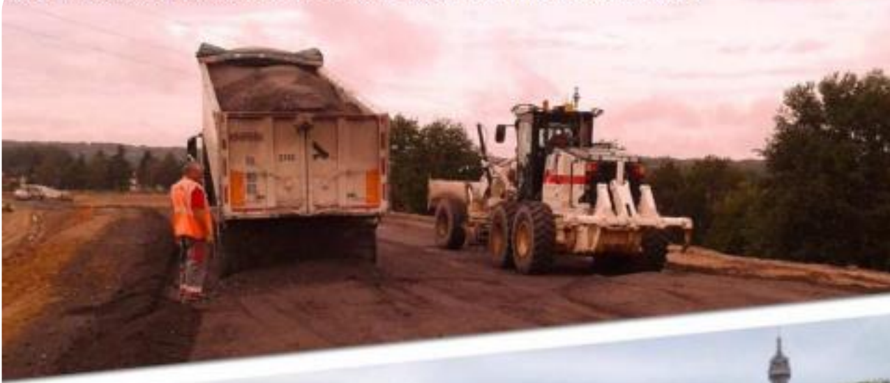
Déviation de VAAS pour le Conseil Général de la Sarthe – 5 000 t de graves de mâchefers valorisées
