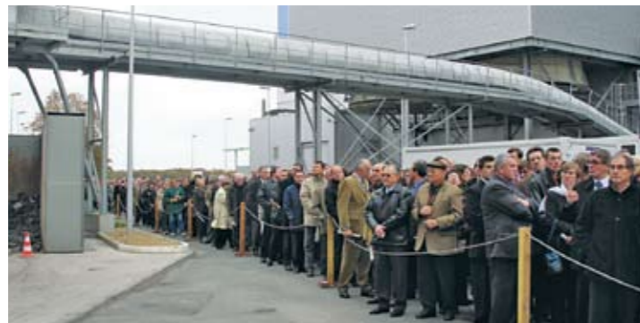
Au cours de deux journées inaugurales, la foule s'est pressée pour découvrir les installations de Salamandre et parcourir son circuit de visite. Un réel succès!
