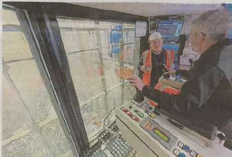
À Lasse, 35 personnes travaillent pour le Sivert et Veolia. Ici, depuis un poste de contrôle, ce salarié pilote le grappin qui vient piocher les déchets avant de les déverser dans le four.
