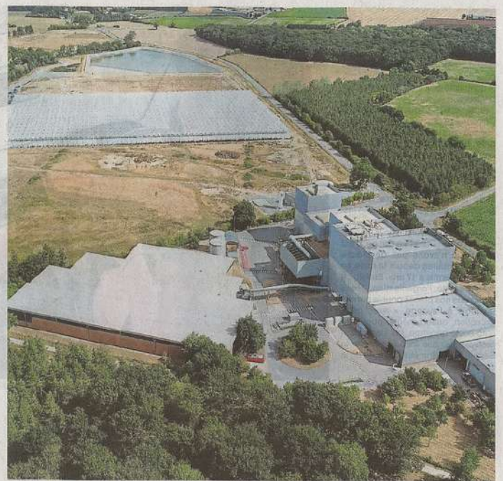
À Lasse, près de Baugé, la combustion de 120 000 tonnes de déchets par an permet de produire de l'électricité, réinjectée dans le réseau, et de la vapeur, pour chauffer des serres de tomates (en haut). Un second four va être construit, ce qui nécessitera d'acquiescer 2,5 ha de terrain, pour y déplacer le bâtiment de gauche.
