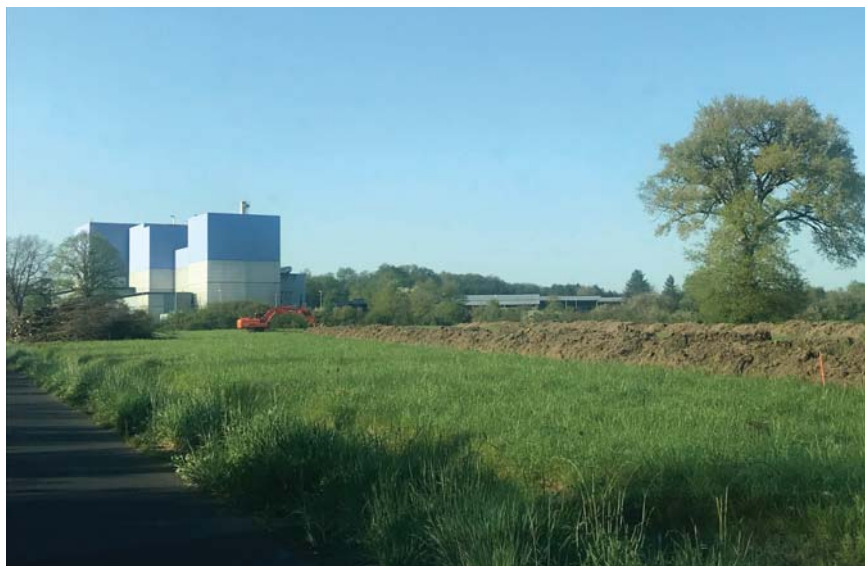
Des serres seront chauffées grâce à la valorisation énergétique des déchets.
