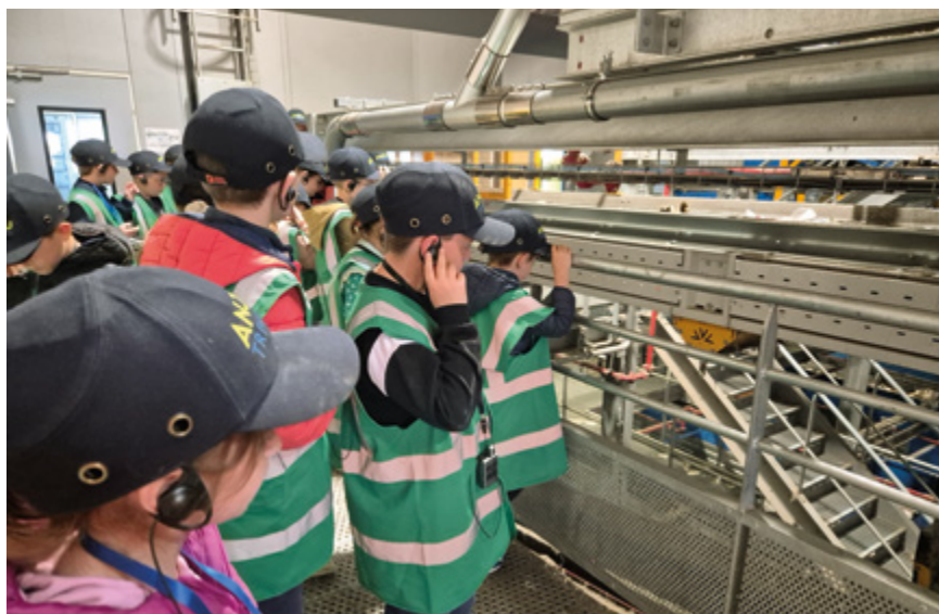
Une classe sur le circuit de visite
