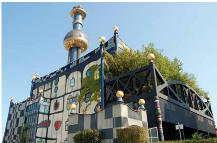
L'Unité de Spittelau à Vienne (Autriche) couvre les besoins en chauffage et eau chaude de 60 000 personnes chaque année, grâce au traitement de 260 000 tonnes de déchets. La décoration est l'œuvre de l'artiste Hundertwasser.
