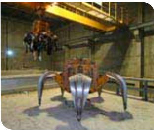
Le grappin : Il peut transporter jusqu'à 2 tonnes de charge à chaque prise. Il y a deux grappins sur le site qui sont utilisés l'un après l'autre, afin d'assurer en permanence l'alimentation du four !
